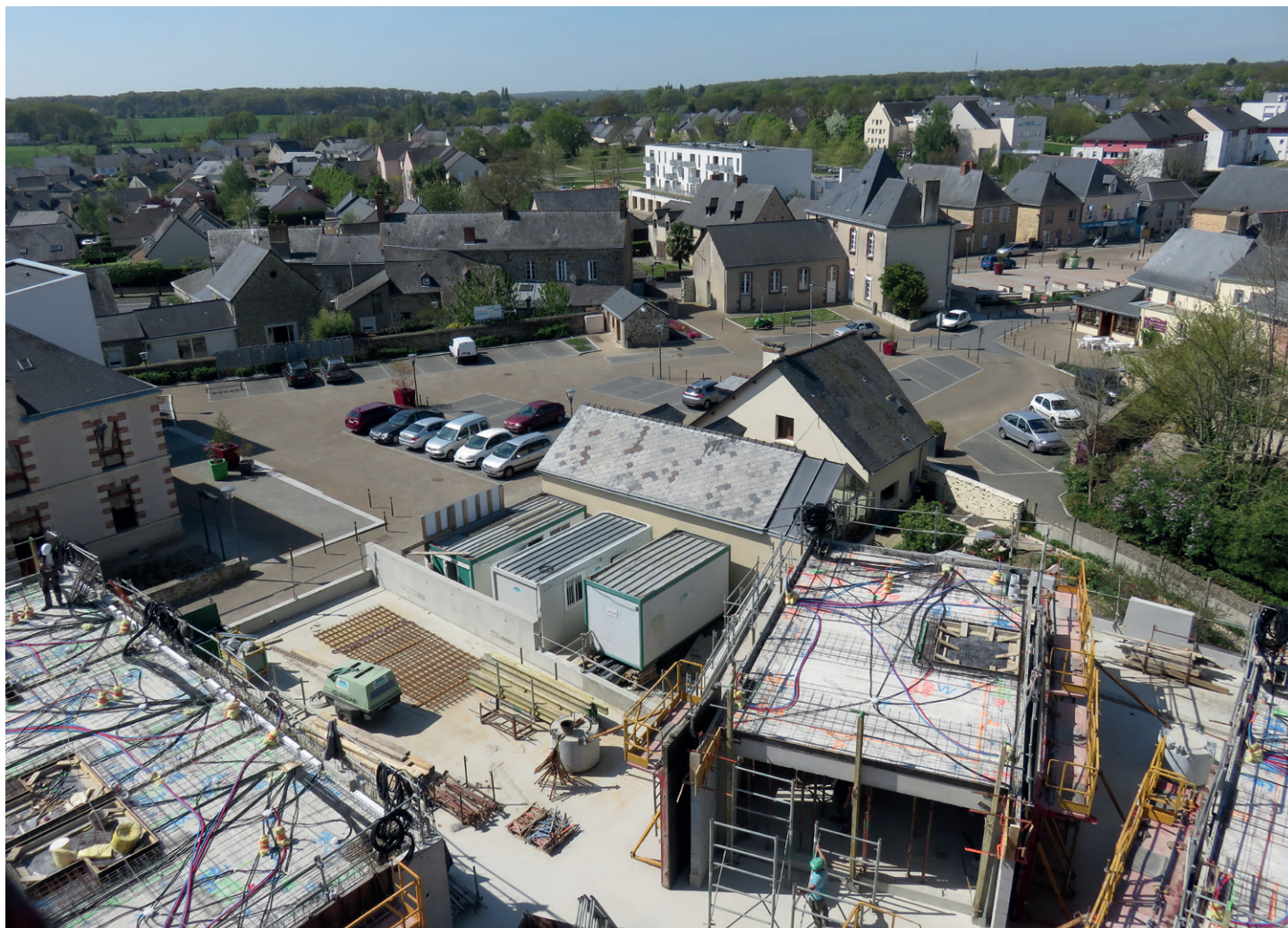
La médiathèque avec ses neuf logements en construction constitueront l'investissement principal de l'année
