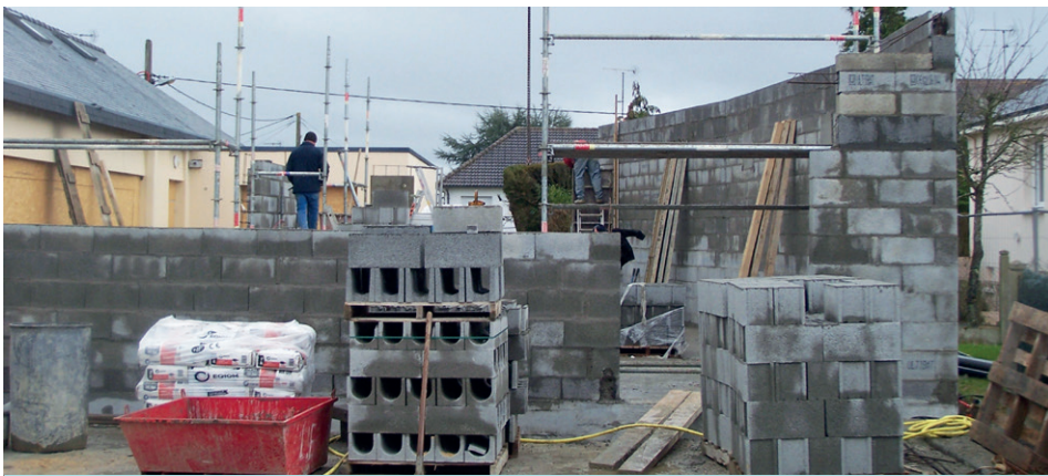
Tout est prêt pour que la dalle de béton puisse être coulée (photo début mars)
