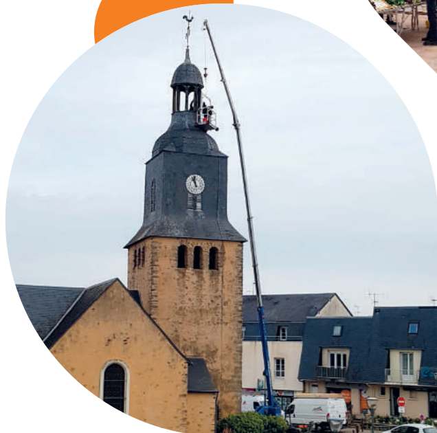
Travaux clocher : 24 jours, c'est le temps qu'il a fallu pour les travaux de restauration de la charpente du clocher de l'église.
